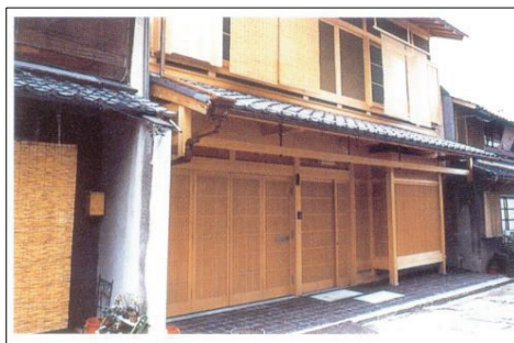
写真8 修理後の本二階建て町家住居 出典:写真7に同じ。
