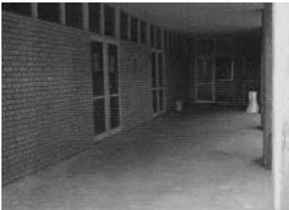
図22. 旧館101教室裏の出入口付近 (図の左側が101教室の一番後ろ)
